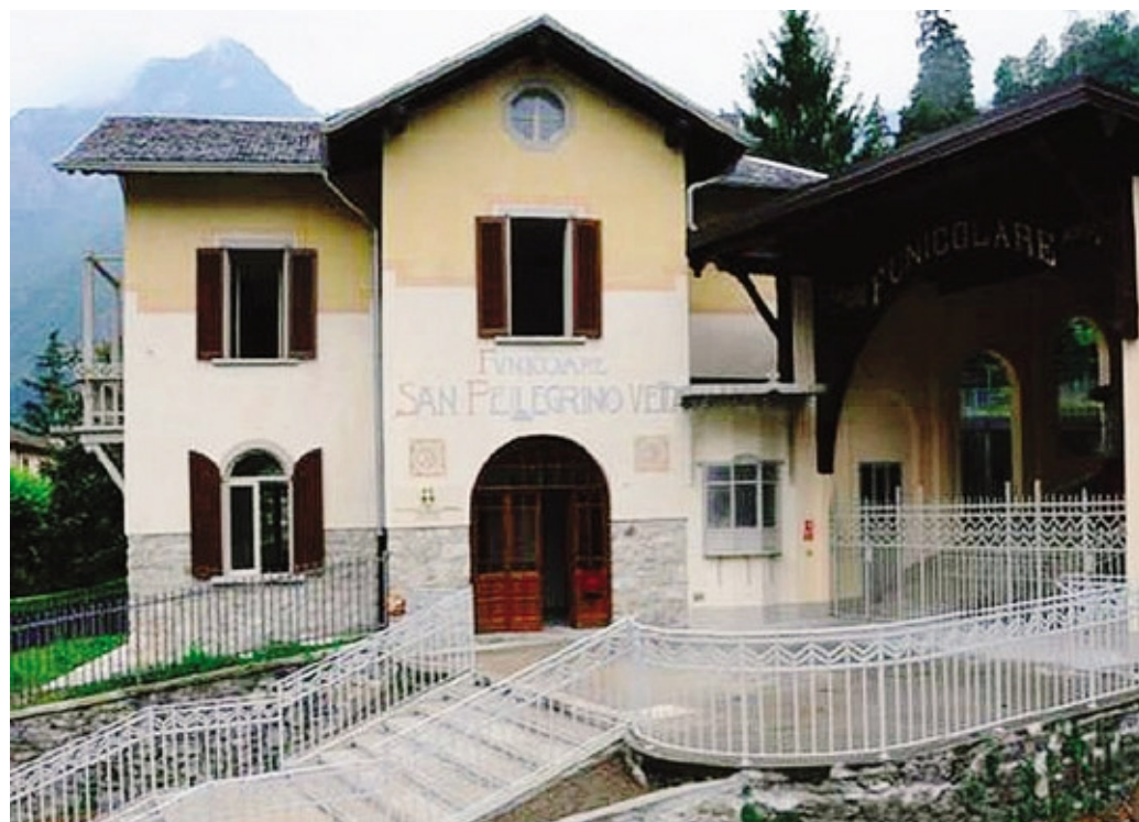
La Villa della funicolare di San Pellegrino: progettazione e lavori furono regolari
