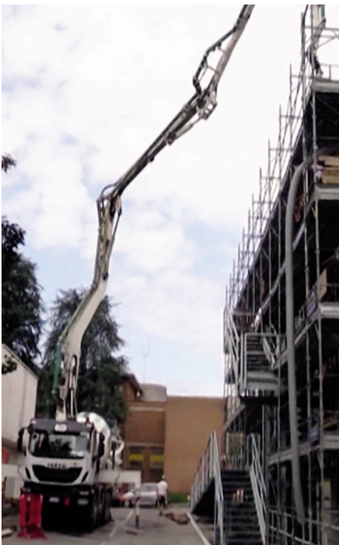
Il cantiere della scuola ad Albano
