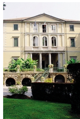
Villa Clorinda, sede del municipio
